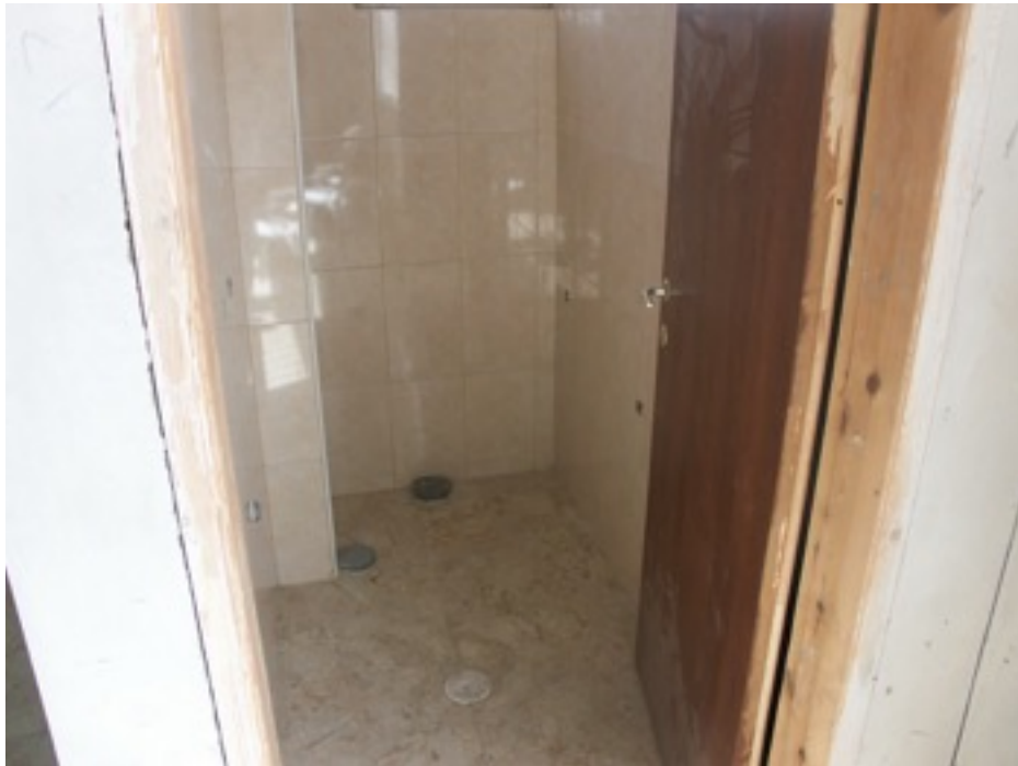
Toilette pas encore terminé
